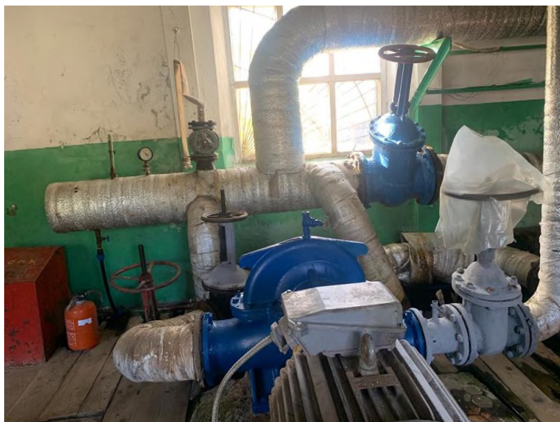
Рисунок 9 – Насосная станция г.Александровск
